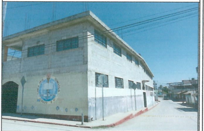
Foto 4: Pintura del establecimiento
