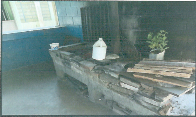
Foto 1: Estado de la cocina
